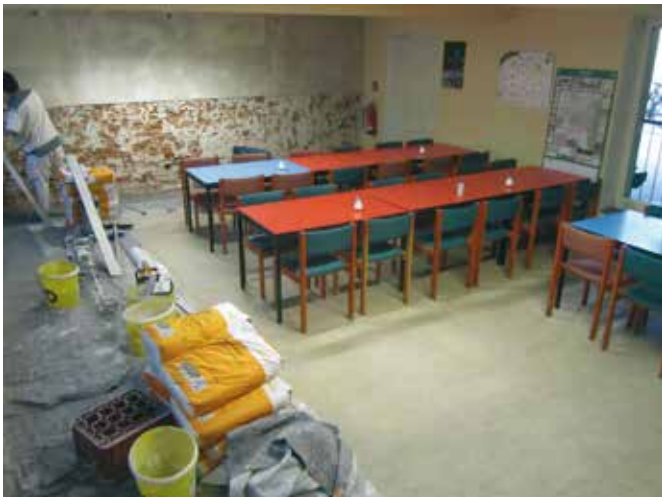
Renovierung der Wärmestube
